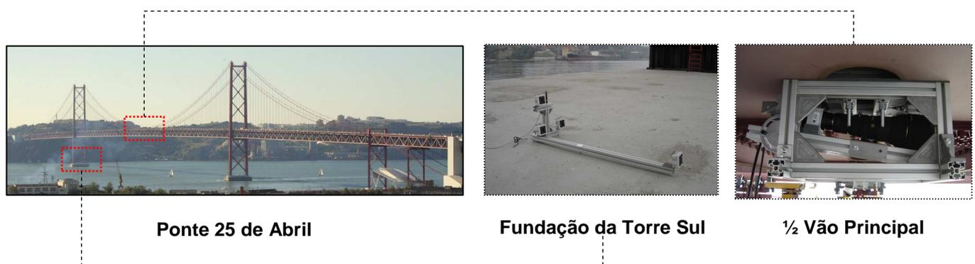
Figura 1 – A Ponte 25 de Abril com localização dos principais componentes do sistema óptico de visão computacional.
